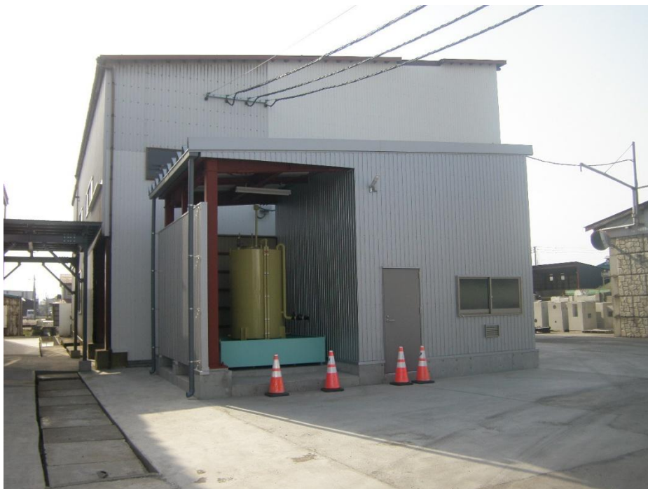
【J社（ボイラー室新築工事）】
